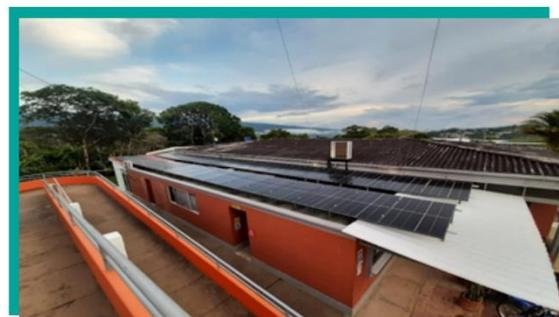
Se instala paneles solares en el bloque administrativo, para uso del cuarto de DATOS. La instalación de los paneles solares contempla un Regulador de Carga, un Inversor y 16 baterías.
